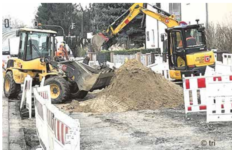
Aktuelle Baustelle Saarstraße in Auerbach
